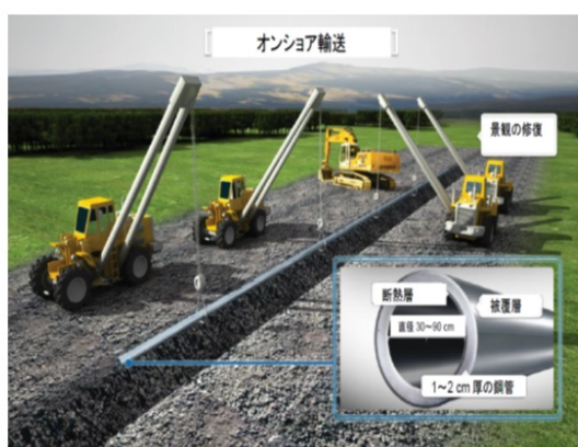
図 3-9 米国におけるパイプライン建設（仮想図）
